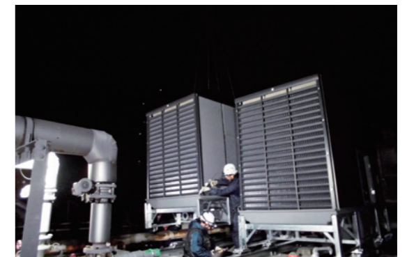
冷却塔更新工事
