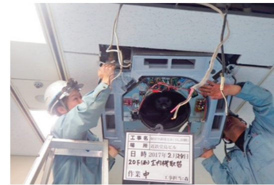
空調機器更新工事
