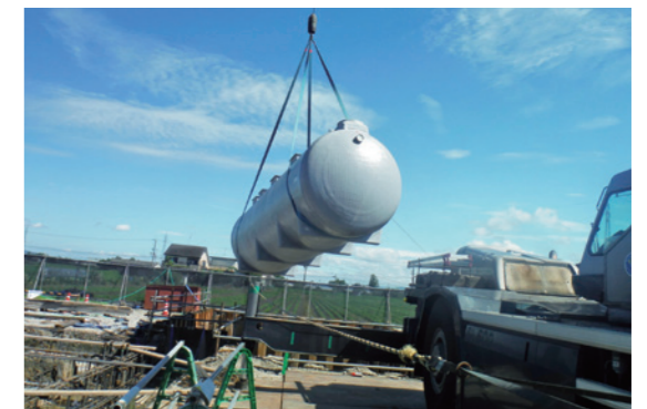
浄化槽設置工事
