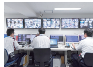
防災センター
