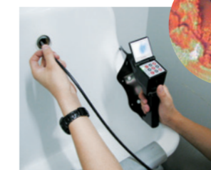
ファイバースコープによる給水管調査
